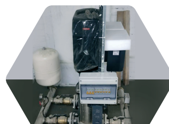
Установка ВНС, г. Новосибирск
