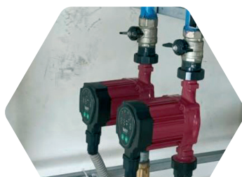
Офисное здание, г. Красноярск
